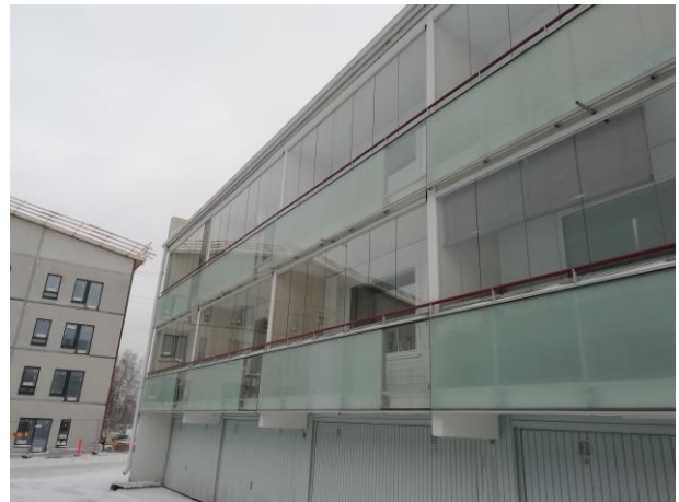
Yleiskuva julkisivusta. Huoneistojen parvek- keita
