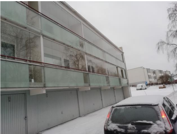
Yleiskuva julkisivusta. Huoneistojen parvek- keita
