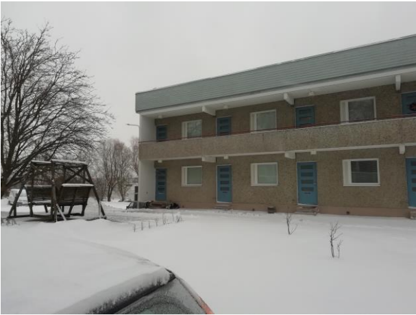
Yleiskuva julkisivusta. Huoneistojen ulko- ovent.
