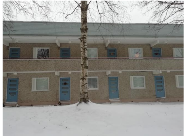
Yleiskuva julkisivusta. Huoneistojen ulko- ovent.
